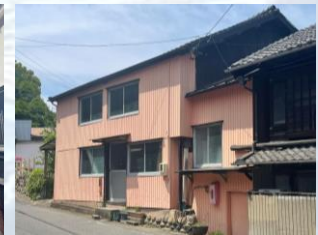
写真3-2 トタン貼りの建物
