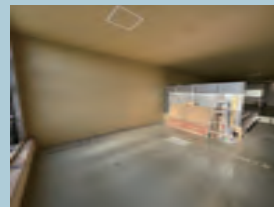
13. 水回り壁・分電盤塗装
