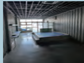
12. 天井・床ボード貼り
