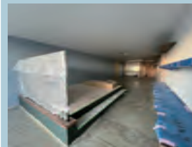
16. 照明・コンセント設置
