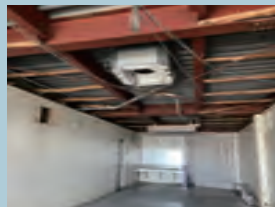
4. 新しい配線の設置
